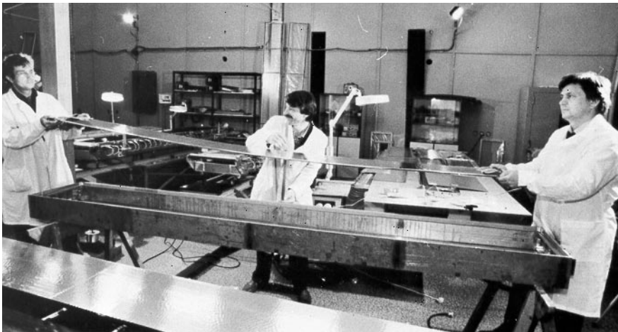
Лаборатория сверхвысоких энергий. Участок сборки серийных модулей камер из покалона-С для установки HERA-B в DESY (ФРГ)
