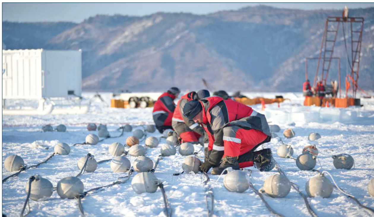
Рис. 12. Сборка гирлянды кластера установки Baikal-GVD
