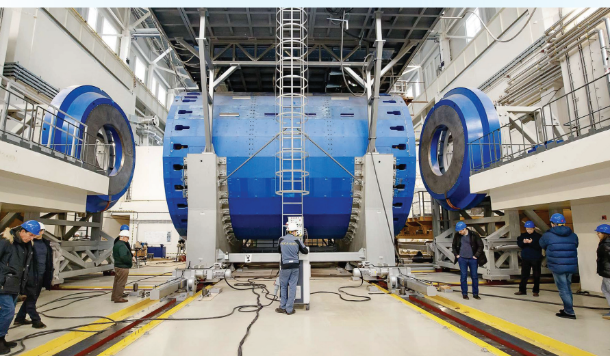
Технологическое перемещение 800-тонного соленоида детектора MPD
