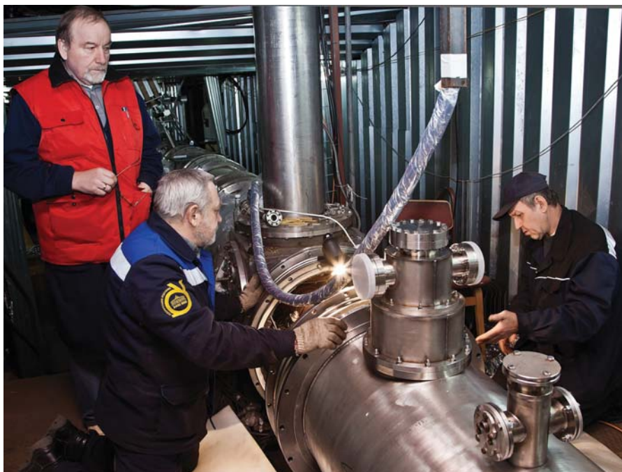
Лаборатория физики высоких энергий им. В. И. Векслера и А. М. Балдина, 27 октября. Завершающий этап установки основных элементов системы стохастического охлаждения ускоренных пучков на кольце нуклотрона
