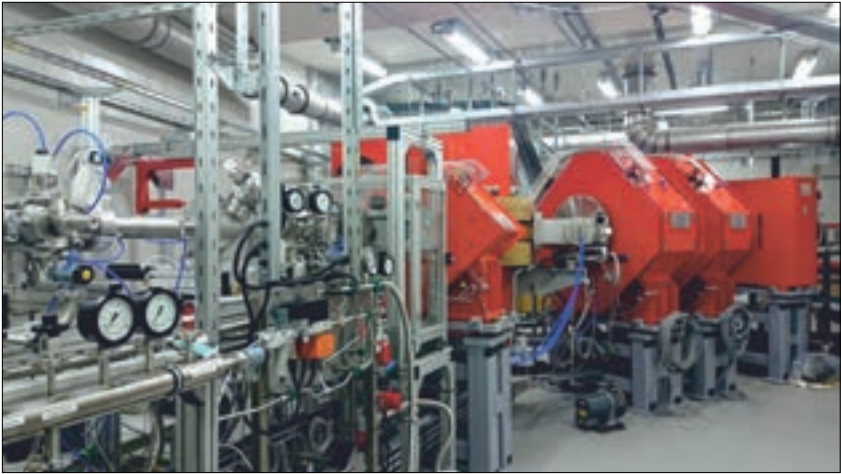
Газонаполненный сепаратор, фабрика СТЭ
