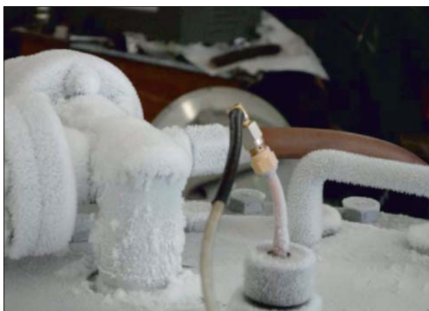
Рис. 4.6. Верхняя крышка криостата с выходным разъемом СВЧ-кабеля
