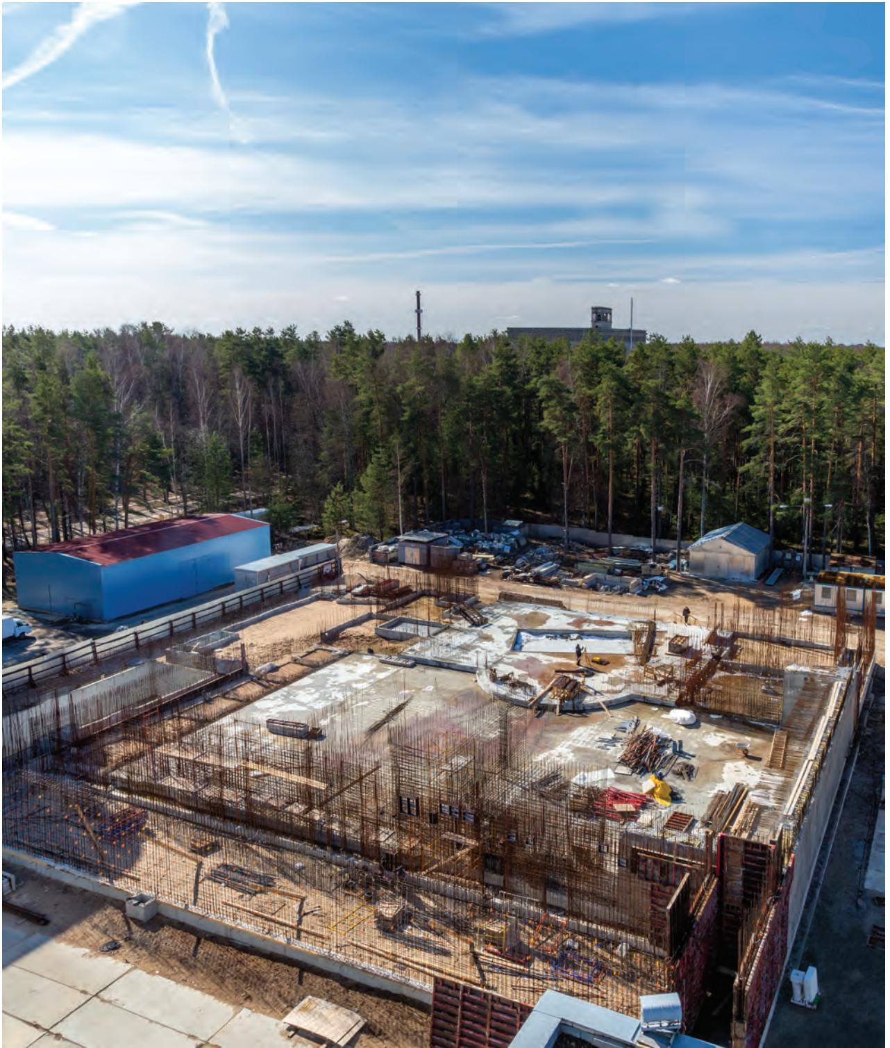
Строительная площадка будущей фабрики сверхтяжелых элементов
